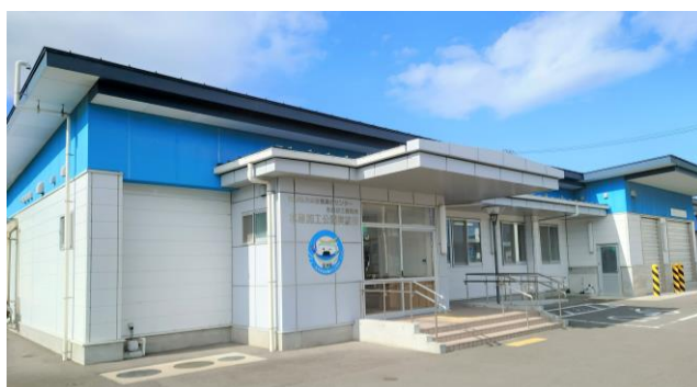
水産加工公開実験棟
