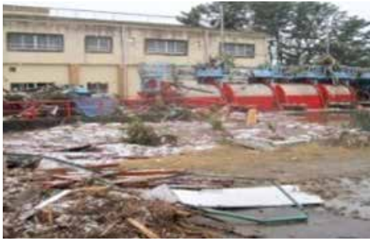
写真 閉上排水機場被災状況（名取市）
