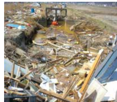
写真 排水路の被災状況（石巻市）
