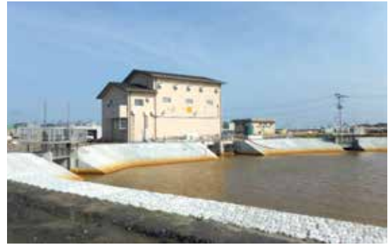
写真 復旧した大曲排水機場
