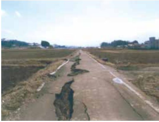
写真 農道の被災状況 (蔵王町和田(1)地区)
