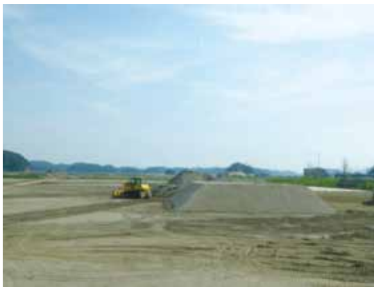
写真 奥松島地区客土施行状況（東松島市 平成27年）
