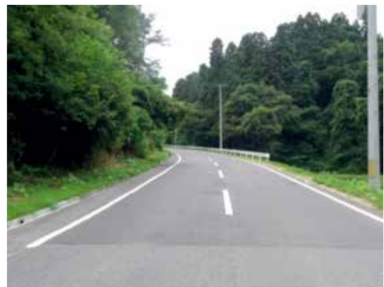
写真 復旧完了状況
