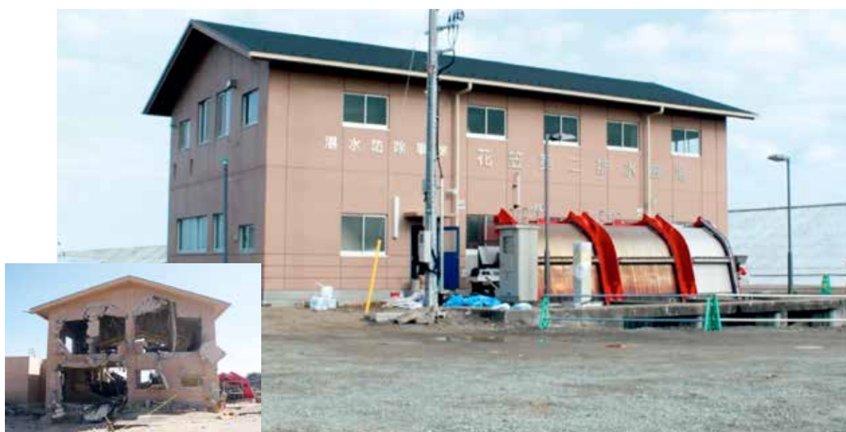
写真 被災状況（平成23年）復旧状況（平成27年2月）
