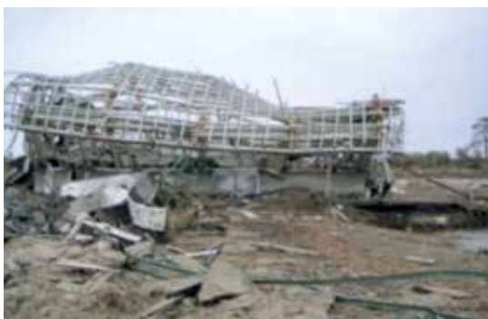
写真 山下第8揚水機場被災状況（山元町）
