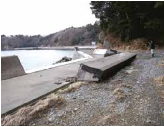
写真 農地海岸の被災状況（南三陸町）
