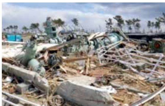
写真 二郷堀排水機場被災状況（仙台市）
