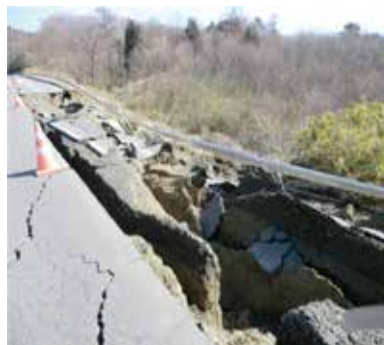
写真 農道の被災状況（蔵王町）
