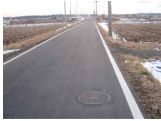
写真 復旧完了状況 (平成24年12月)
