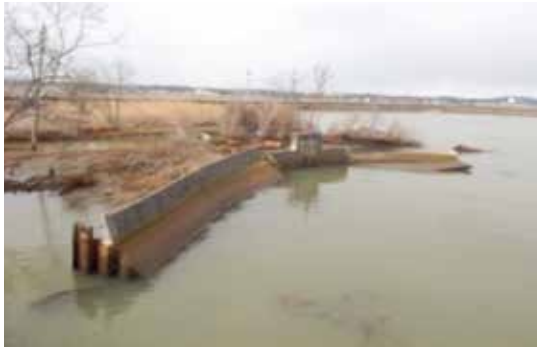
写真 大曲排水機場被災状況（東松島市）
