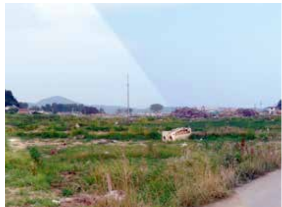
写真 最知工区被災状況（平成23年）
