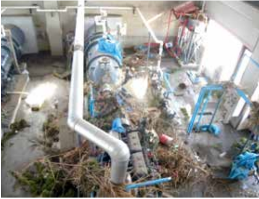
写真 被災直後の排水機場（平成23年3月）
