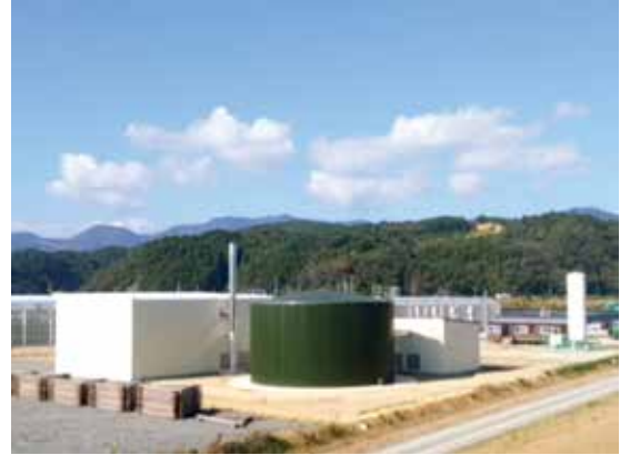
写真 エネルギー供給施設
