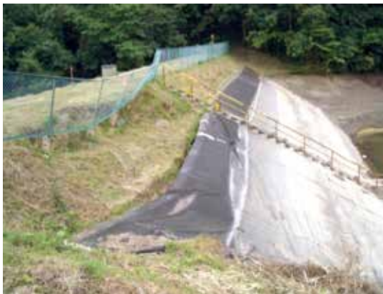
写真 被災した松沢ため池 (大衡村)
