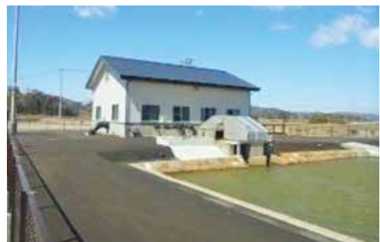
写真 復旧した山下第8揚水機場
