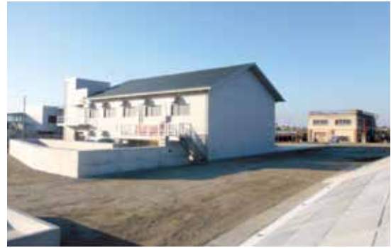
写真 復旧した閉上排水機場
