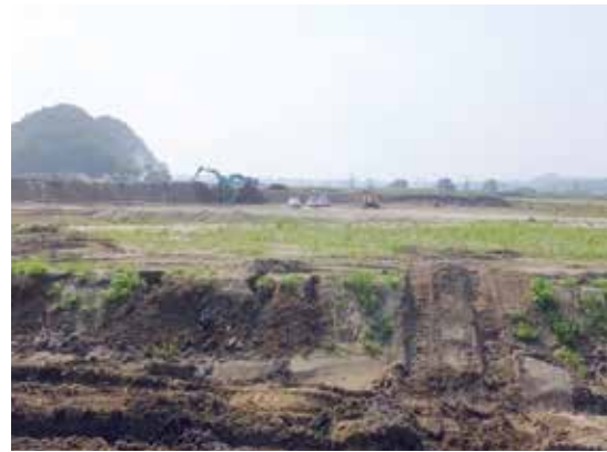
写真 奥松島地区復旧状況（平成27年）
