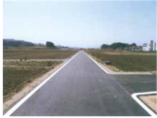
写真 復旧完了状況
