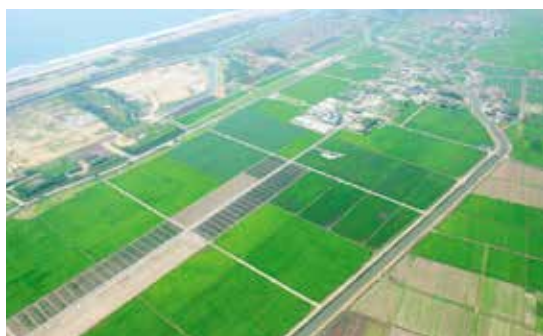
写真 仙台東地区農地復旧状況（平成27年）
