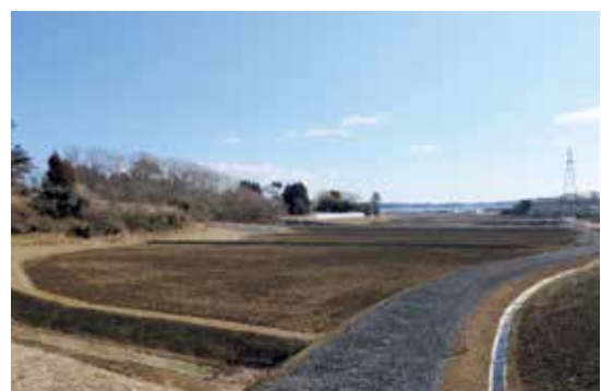
写真 最知工区復旧状況（平成28年）
