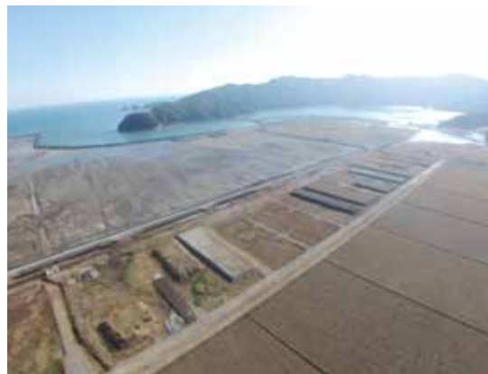
写真 大川地区客土施行状況（石巻市 平成27年）
