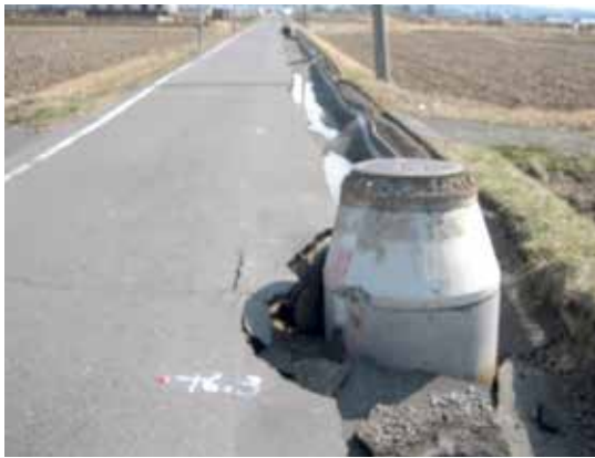
写真 農業集落排水管路施設の被災状況 (大崎市高柳地区)
