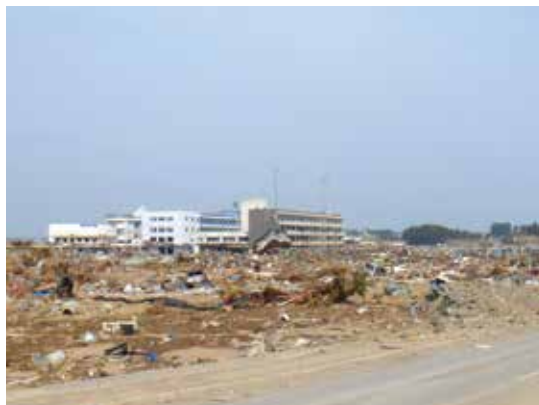
写真 杉ノ下工区被災状況（平成23年）
