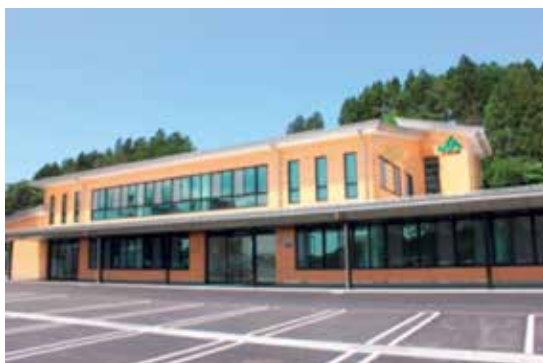
写真 復旧した南三陸農業協同組合本店・志津川支店
