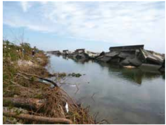
写真 農地海岸の被災状況（巨理町）
