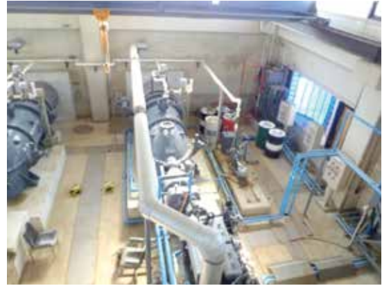
写真 応急復旧後の排水機場（平成24年3月）
