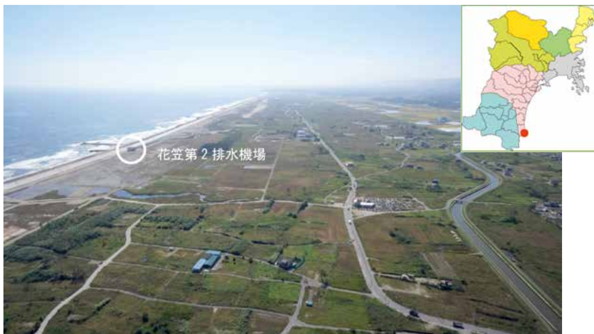
写真 山元東部地区工事着手前（平成27年9月）
