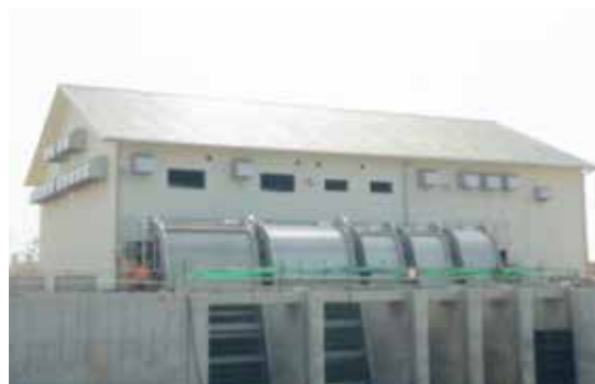
写真 復旧された二郷堀排水機場
