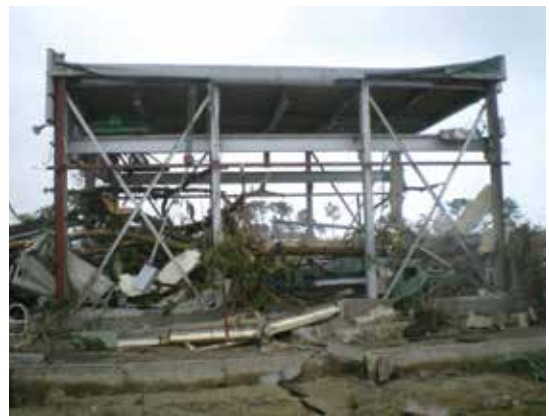
写真 排水機場の被災状況（仙台市）
