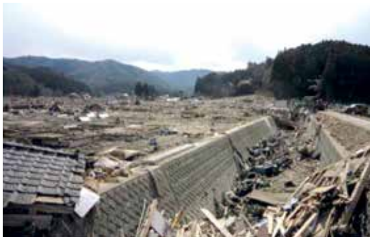
写真 西戸川工区被災状況（平成23年）
