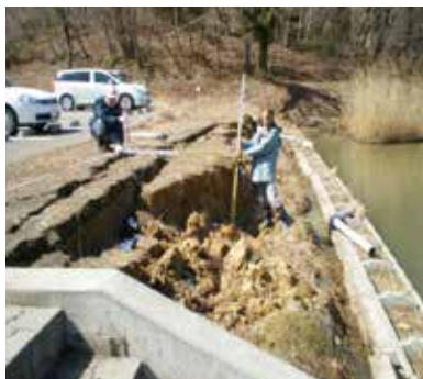
写真 ため池の被災状況（白石市）
