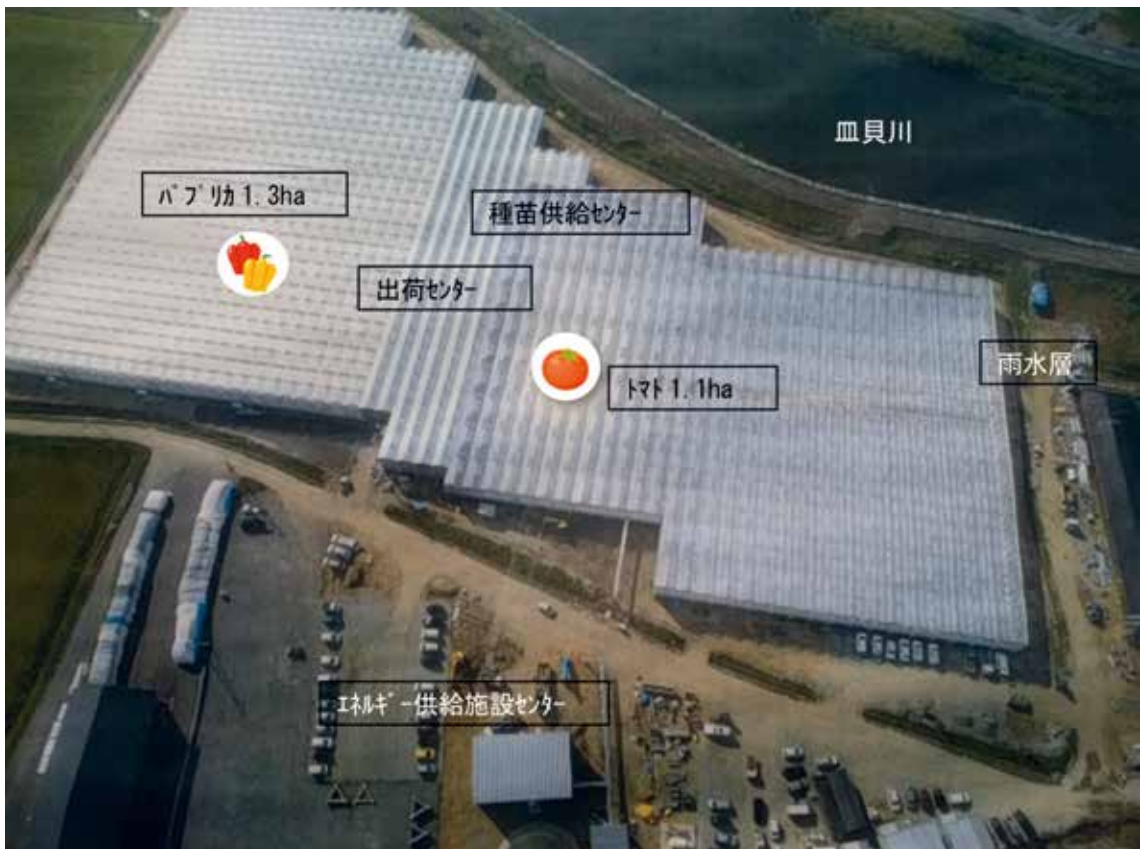
写真 施設整備完了 平成28年8月完成（全景写真）
