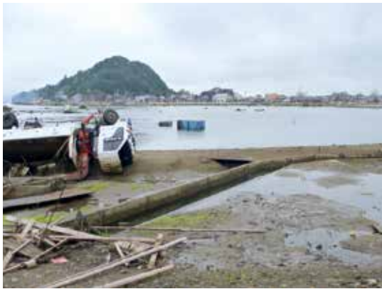
写真 奥松島地区被災状況（平成23年）
