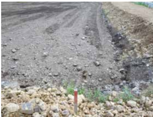
写真 表土に含まれる石礫の状況
