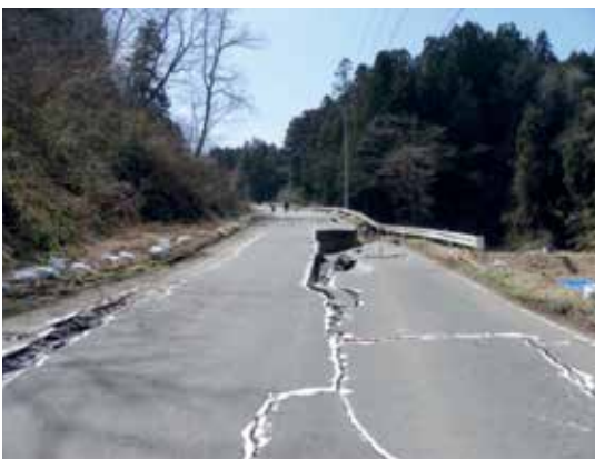
写真 農道の被災状況 (栗原市一迫松の木地区)
