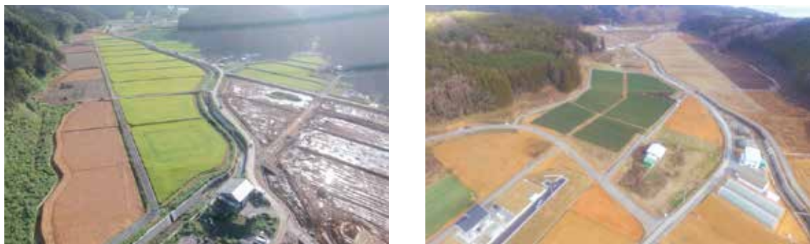
写真 西戸川工区復旧状況（平成27年）
