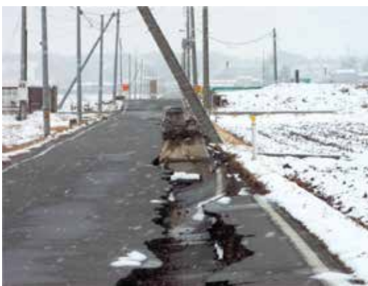
写真 農業集落排水処理施設の被災状況（大崎市）
