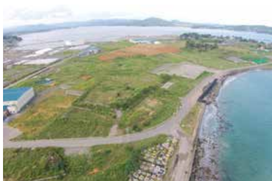
写真 杉ノ下工区復旧状況（平成27年）
