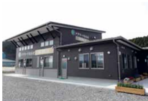
写真 農産物処理加工施設「NOBICO=のびこ」（東松島市）（ク）
