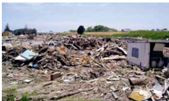
写真 仙台東地区農地被災状況（仙台市）
