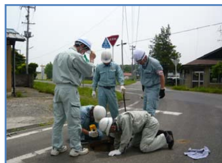
管きよ・マンホールの全量目視調査の状況
