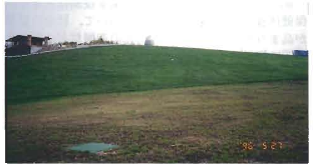
ネオソイルを使用して緑化された斜面
