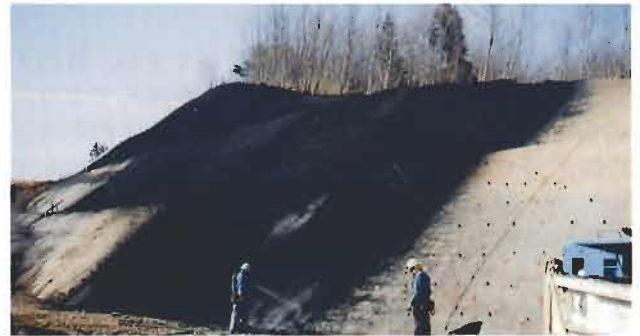
斜面緑化のためネオソイルの吹付けを実施
