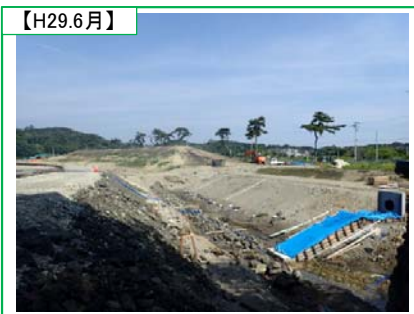
◆今後（来年の夏頃にはこんな感じになってます） 平成30年度の完成をめざし、引き続き防潮堤の被覆ブロック設置工を進めます。
