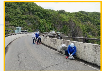
ダム堤体上 土砂撤去作業
