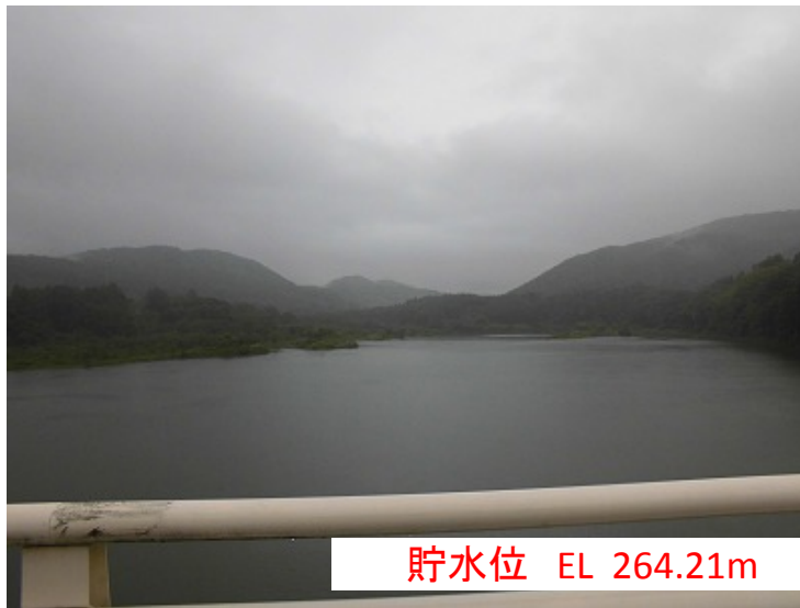
大倉大橋上流側(洪水後 8月9日 6時10分)
