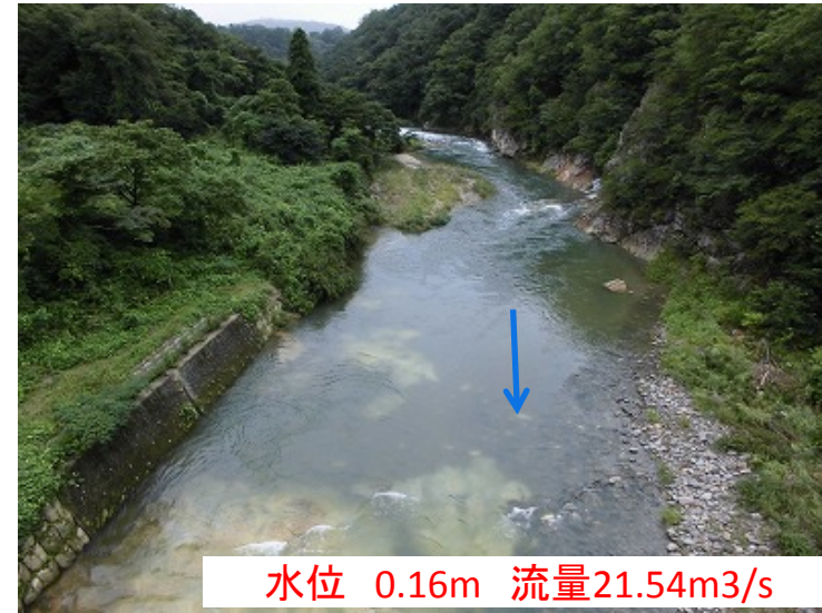
白沢水位観測所(洪水前 8月8日 6時50分)
