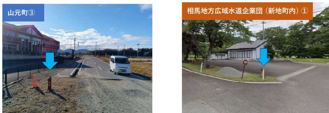
図 4-9 応急給水栓（消火栓）の設置状況例
