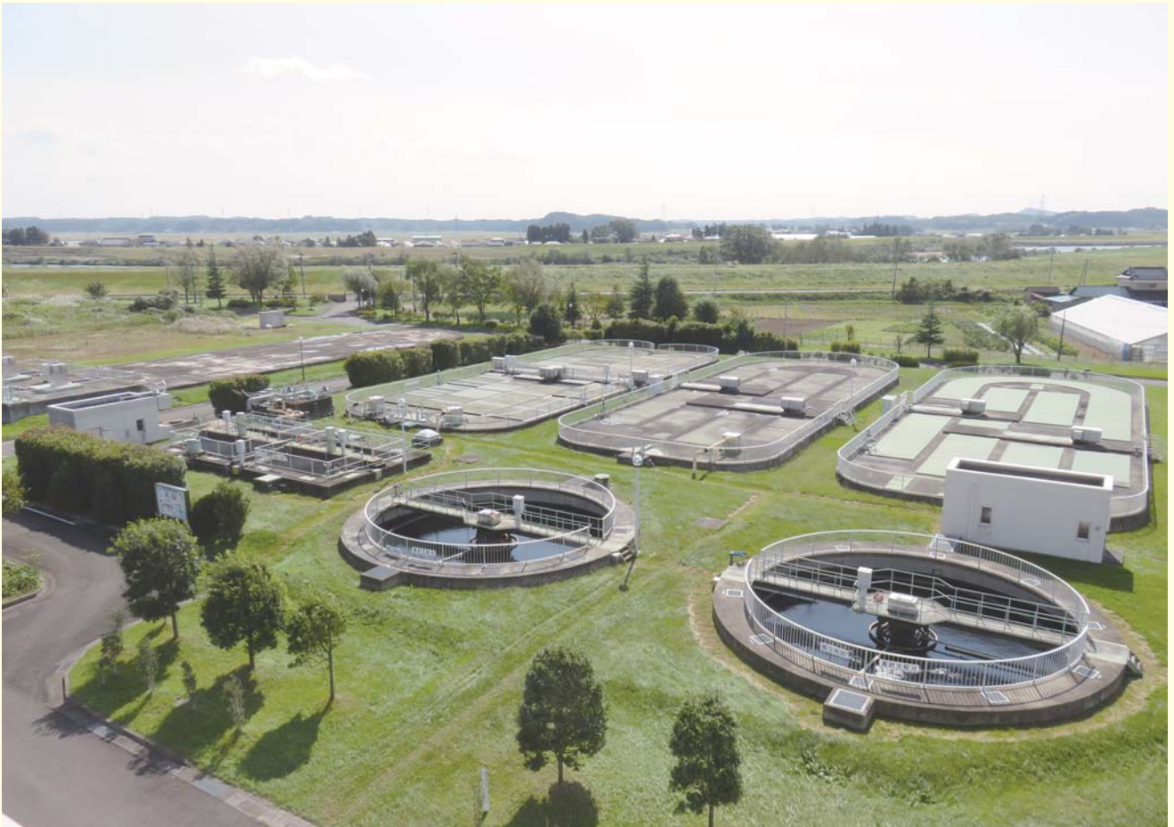
オキシレーションディッチと最終沈殿池
