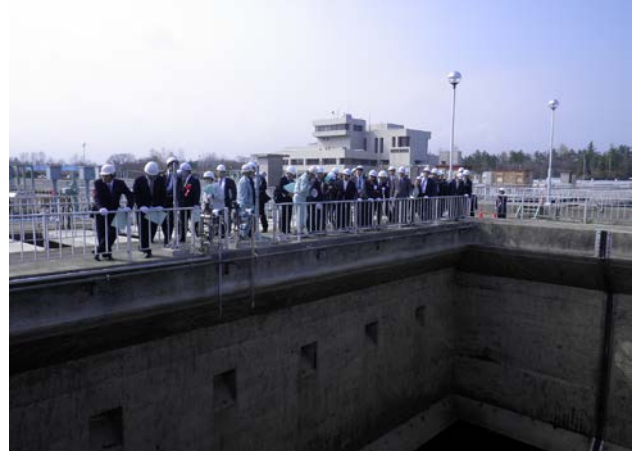
復旧工事視察(第1系列:復旧工事中)
