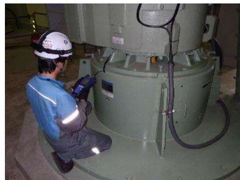
設備点検状況
