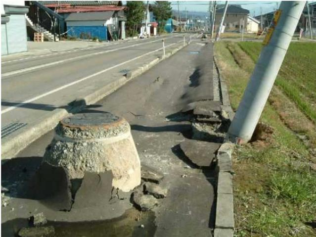
中越地震時の人孔浮き上がり現象 (新潟県HPより)
