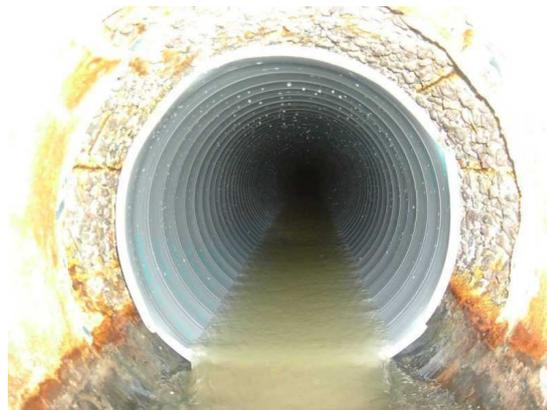
管渠補修後（製管が完了）
