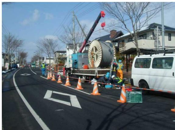
製管工法による管渠補修状況
