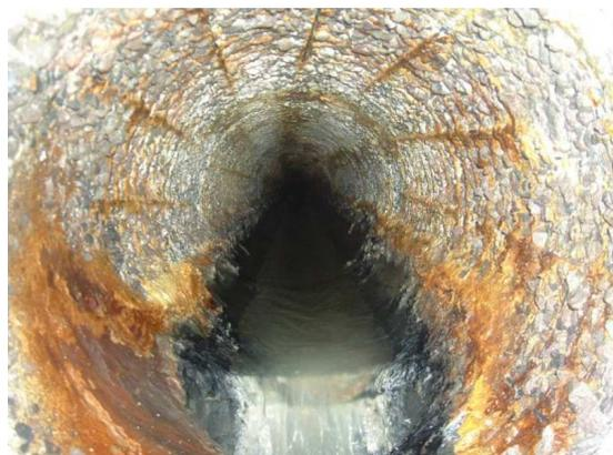
管渠補修前（鉄筋と骨材の露出状況）
