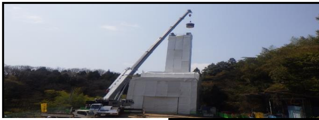
写真2 煙突撤去状況
