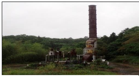
写真1 解体前焼却施設全景
