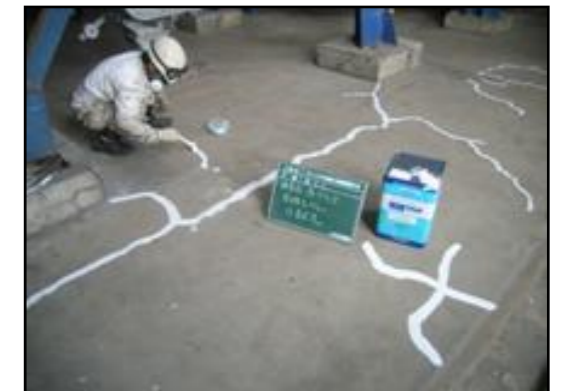
土間コンクリート亀裂補修(他事例)
