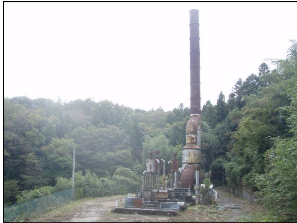
解体撤去する焼却施設本体
