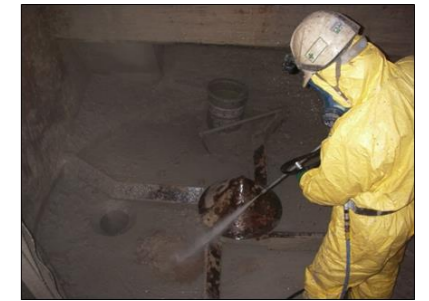
高圧洗浄による除去作業(他事例)
