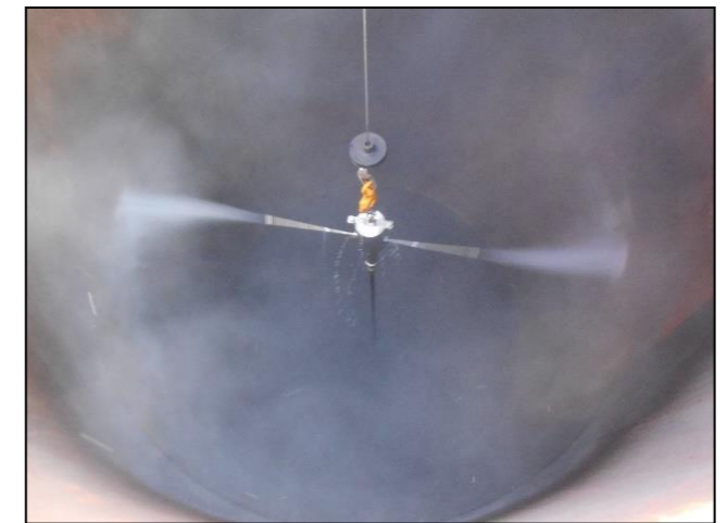
煙突ダイオキシン類除去作業(他事例)
