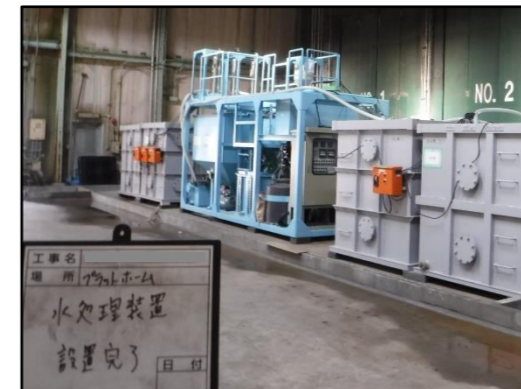
仮設濁水排水処理設備, 流出防止堤(他事例)
