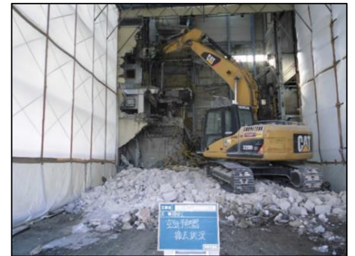
解体工事(他事例)
