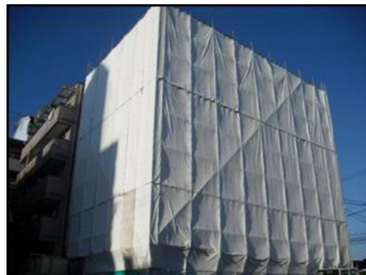
仮設密閉養生による隔離(他事例)
