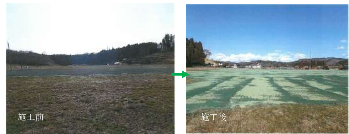
図 3.6 追加対策 整形覆土状況
