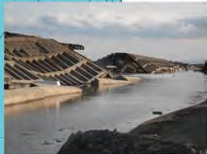
岩沼市二の倉海岸の被害状況
