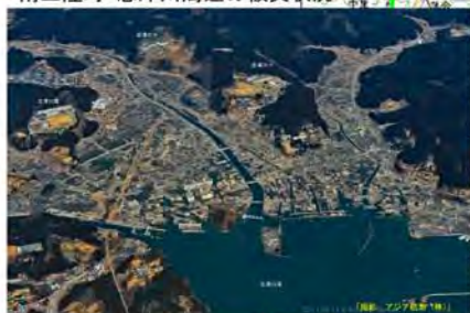
南三陸町 志津川周辺の被災状況
