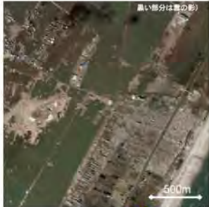
被災後（平成23年3月12日撮影）
