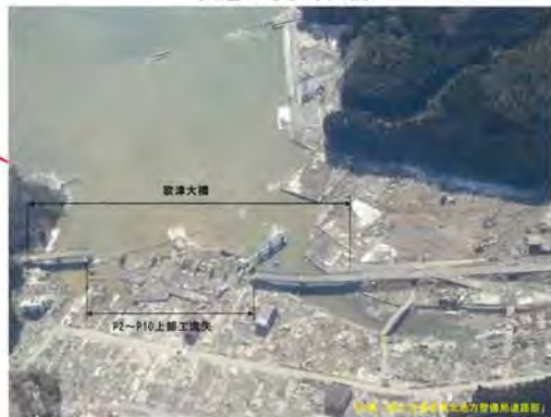
国道45号歌津大橋
