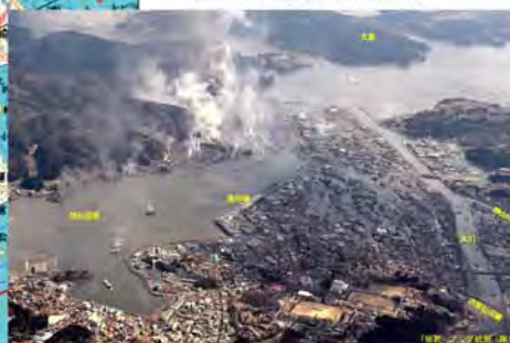
気仙沼市街地の被災状況
