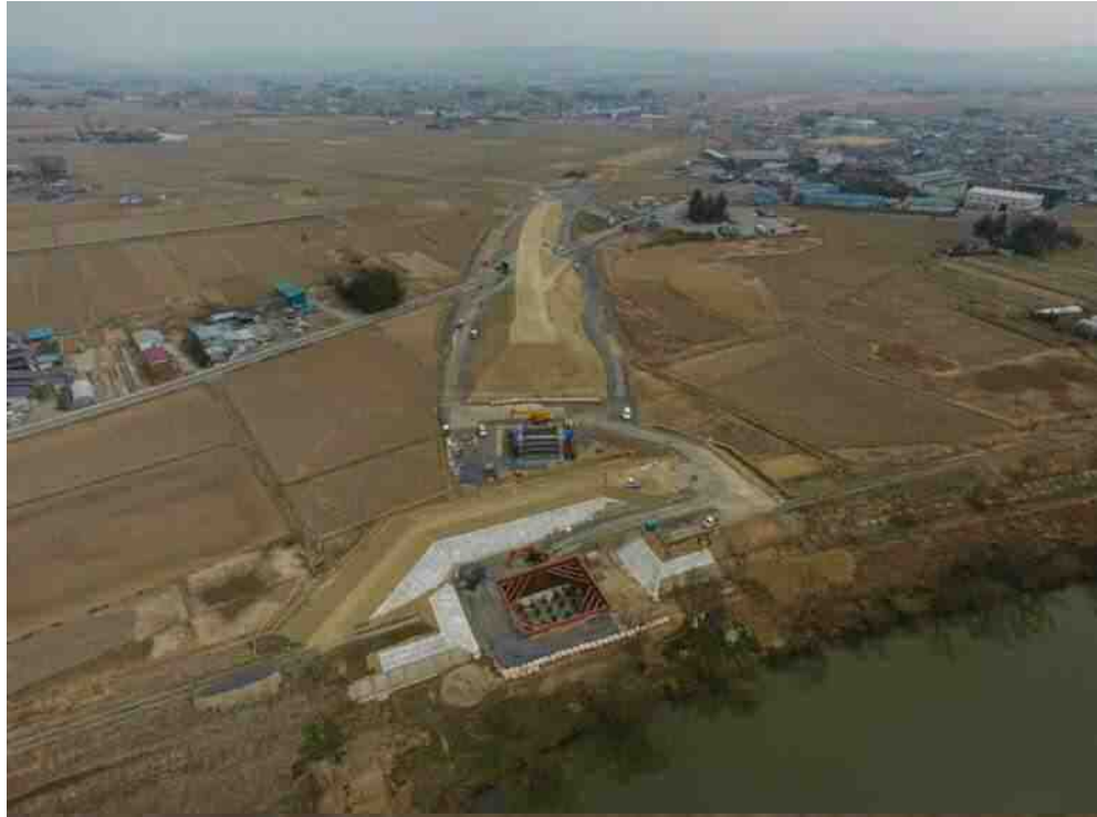
紫雲山大橋（迫川左岸）架橋予定位置
