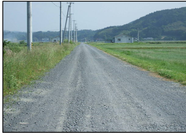
農道の現況 (不陸が生じやすく、維持管理に苦慮している)
