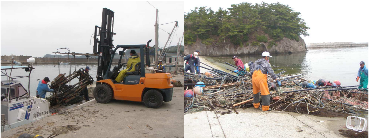
宮戸室浜地区での作業風景
