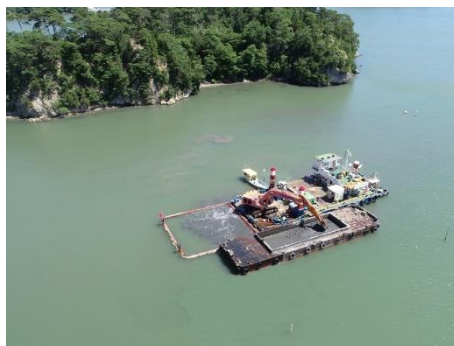
浚渫作業の様子
