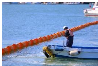
作業船による展張作業
