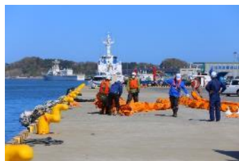
オイルフェンス接続作業
