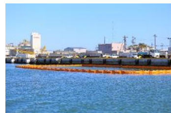
オイルフェンス展張完了
