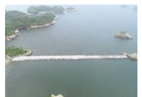
馬放島北防砂堤外消波ブロック設置工事
