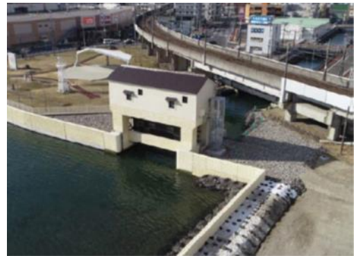
海岸通り水門
