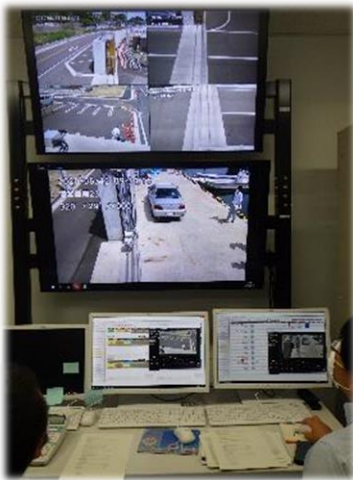
仙台塩釜港湾事務所内
