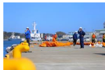
オイルフェンス接続完了
