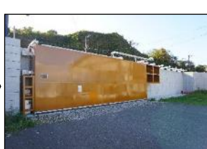
七ヶ浜2エリア(東宮浜)自動化陸閘(七ヶ浜町東宮浜地内)
