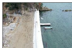
小浜(B)防波堤消波ブロック設置工事(その3)(七ヶ浜町花洲浜地内)
