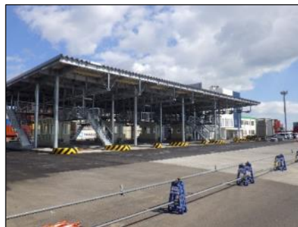
トラックゲート(完成)
