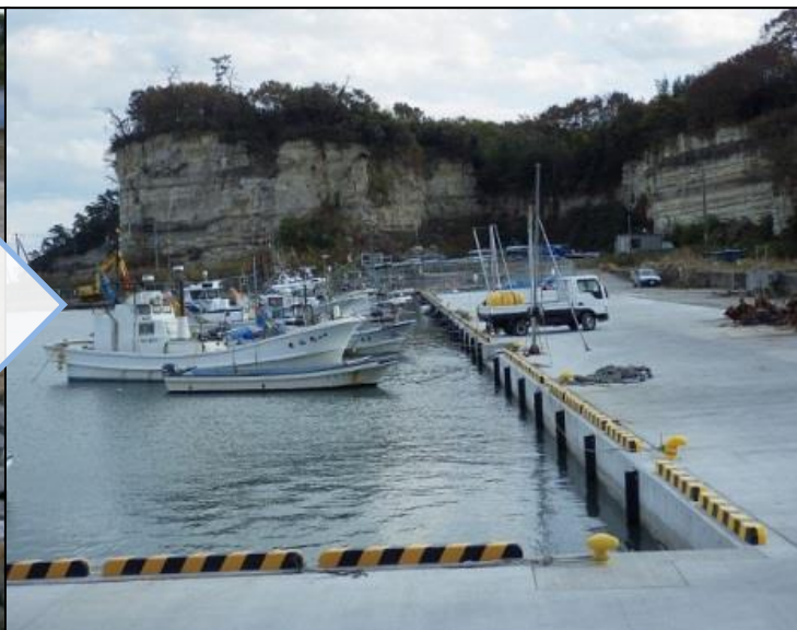
部分完成 (H27年10月)
