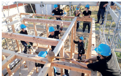
実習では実物大の家屋を製作し、家の各部材や名称、家が建つまでの流れなどを実践を通して習得します。
