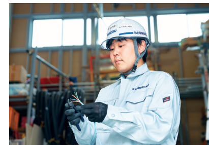
通信に用いるLANケーブルを加工の様子。専門校での実技科目で学んだ基本的な技術は、今の仕事に活かされています。
