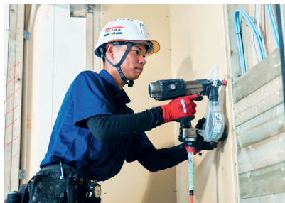
天井や壁に石こうボードを貼る作業では、割れや傷に注意しながら、きれいに仕上げることを心がけています。
