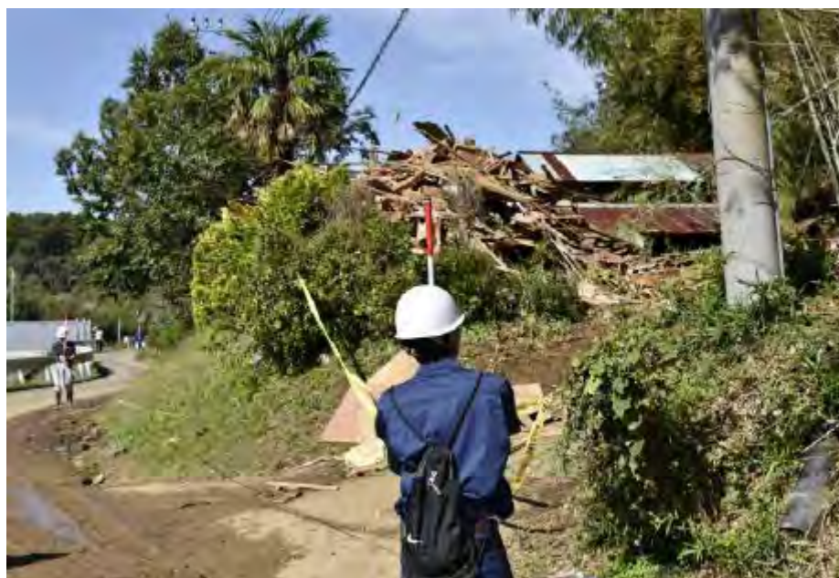
土砂災害で倒壊した住宅。男性の遺体が見つかった。(千葉県千葉市緑区) ※令和元年10月26日 日本経済新聞記事
