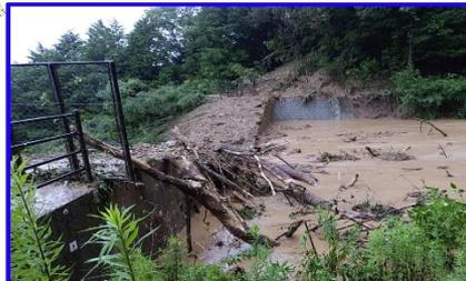
施設効果事例 (堰堤により土石流を捕捉)
