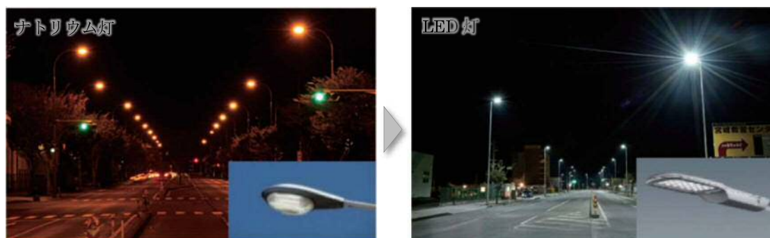
▲ 道路照明灯LED化の実施
