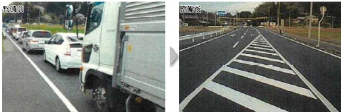
▲ 交差点改良による渋滞対策 〔(主)仙台三本木線 落合相川交差点 (大和町)〕
