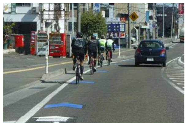
出典：国土交通省東北地方整備局 ▲ 矢羽根型路面表示設置の状況 〔(国)45号（七ヶ浜町）〕
