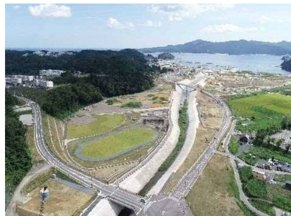
▲ (国) 398号（志津川工区）
