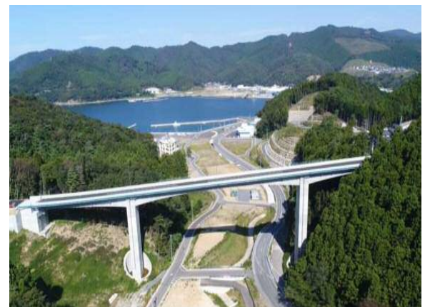
▲ (主) 女川牡鹿線（小乗浜工区）
