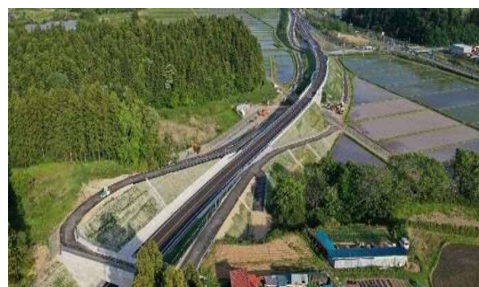
▲ Ⅳ期（築館工区）
