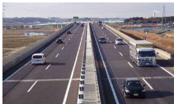
▲ 三陸沿岸道路 4 車線化 (仙台港北 IC～利府中 IC)
