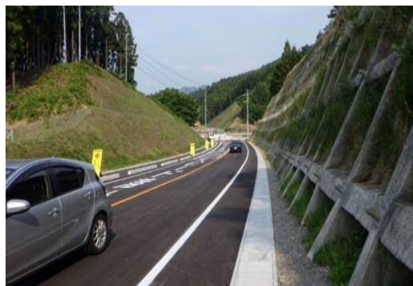
▲ (主) 石巻鮎川線 (風越2工区)
