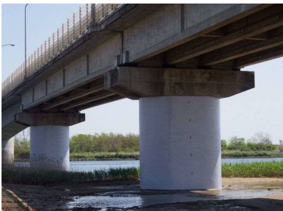
▲（主）塩釜亘理線（関上大橋）耐震補強事例
