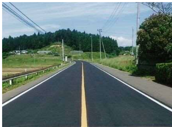
▲（国）113号 舗装補修事例
