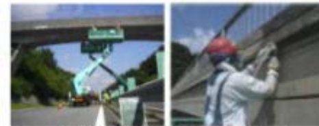
点検実施状況
