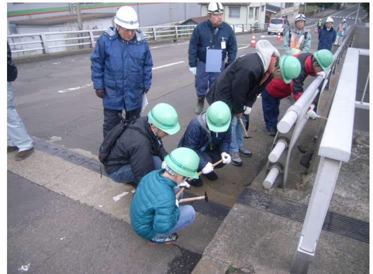
平成26年度 現地見学会の様子(伸縮装置を見学)(H26.11.15)
