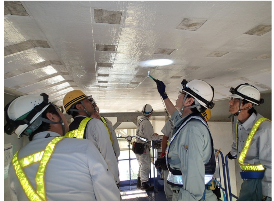
平成26年度 橋梁点検現地研修の様子(H26.9.10)
