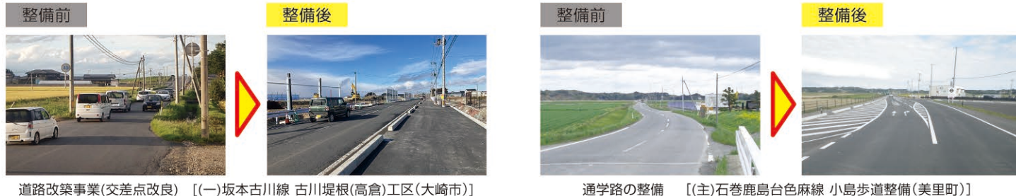
道路改築事業(交差点改良) [(一)坂本古川線 古川堤根(高倉)工区(大崎市)]
