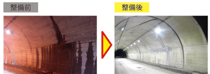
漏水対策の実施 [(国)113号 小原4号トンネル(白石市)]
