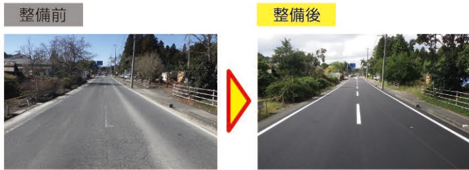
舗装補修 [(国)457号(大和町)]
