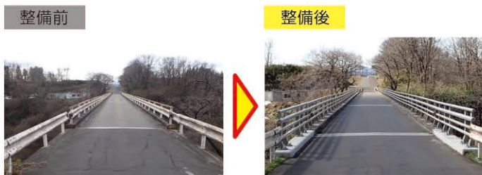
橋梁の補修 [(一)秋保温泉川崎線 滝見橋(川崎町)]
