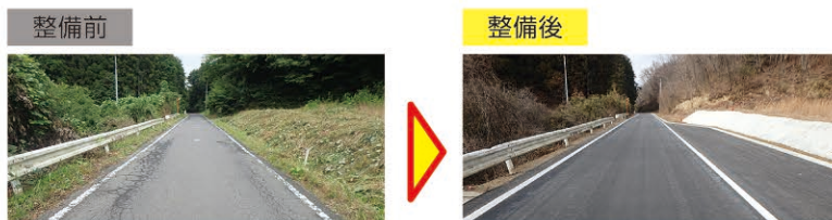
道路改築事業(地域協働) [(一)川前白石線 大鷹沢三沢工区(白石市)]
