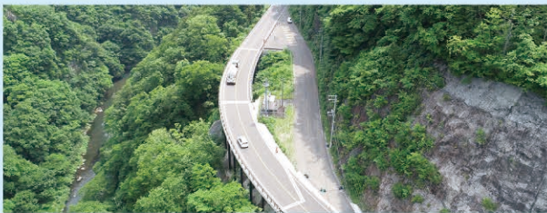
部分供用開始区間
