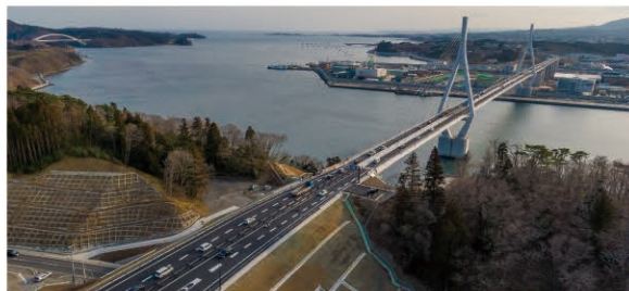
三陸沿岸道路(気仙沼港IC～唐桑半島IC間) 令和3年3月 開通
