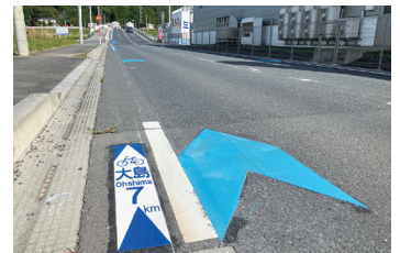
自転車走行環境の整備 [(一)大島浪板線(気仙沼市)]
