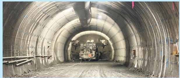
トンネル施工状況
