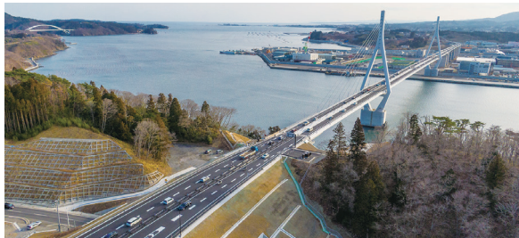
三陸沿岸道路(気仙沼港IC～唐桑半島IC間)令和3年3月 開通
