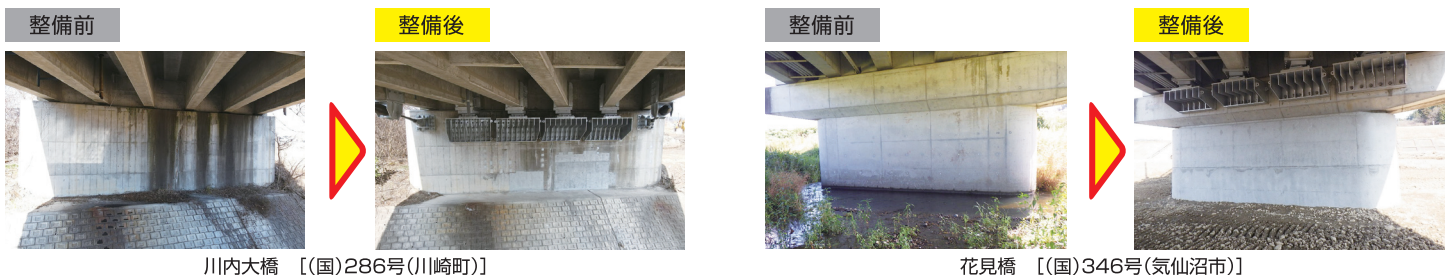
整備前 川内大橋 [(国)286号(川崎町)]
