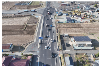
仙台空港周辺道路の整備 [(主)仙台岩沼線 愛島笠島(1)(名取市)]
