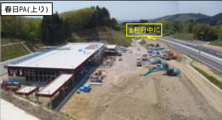
施設建築工事:鉄骨建方完了、屋根・外壁施工中
