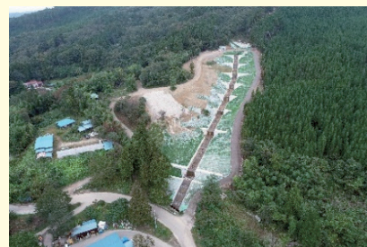
治山事業による復旧状況(山腹工)
