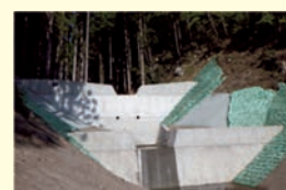
治山事業による復旧状況(治山ダム工)
