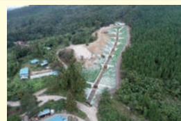
治山事業による復旧状況(山腹工)
