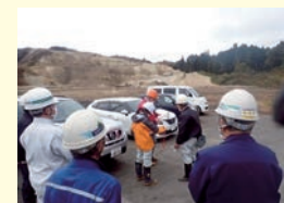
林地開発現場のパトロール状況
