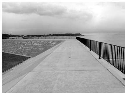
写真－7 復旧した防潮堤（南三陸町長須賀）
