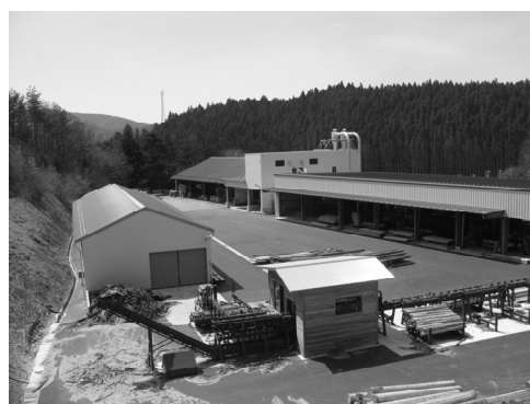
写真－9 復旧した製材工場（南三陸町）
