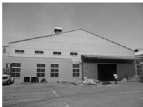
写真－8 復旧した合板工場（石巻市）
