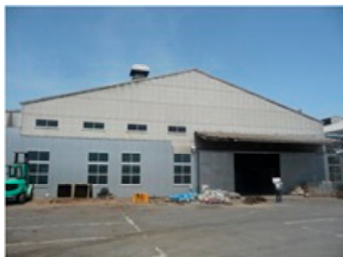
写真－8 復旧した合板工場 (石巻市)
