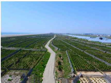
写真－6 海岸防災林の植栽 (名取市)
