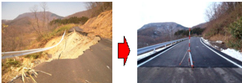
写真-5 復旧した林道（大和町高倉線）
