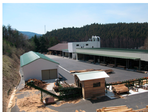
写真－9 復旧した製材工場 (南三陸町)
