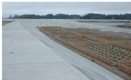
写真－7 復旧した防潮堤と防災林 (東松島市)
