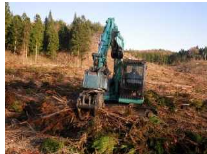
（一貫作業における機械地拵えの様子）
