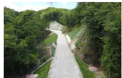
（開設状況（七ツ森湖工区））
