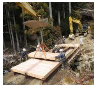
(支障木を地産地消した ＣＬＴ仮設橋)
