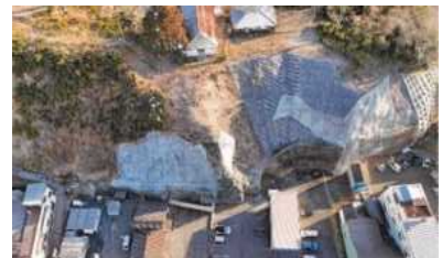
(山腹工による落石防止対策)
