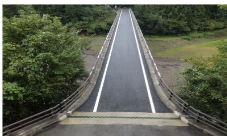
林道「内ノ目線」橋梁の老朽化対策
