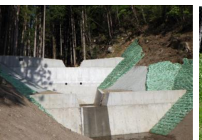
治山施設(治山ダム)
