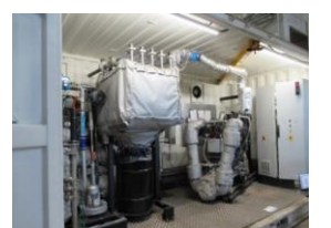
小型木質バイオマス熱電供給施設
