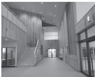
大崎市鳴子総合支所の新築にはCLTを活用
