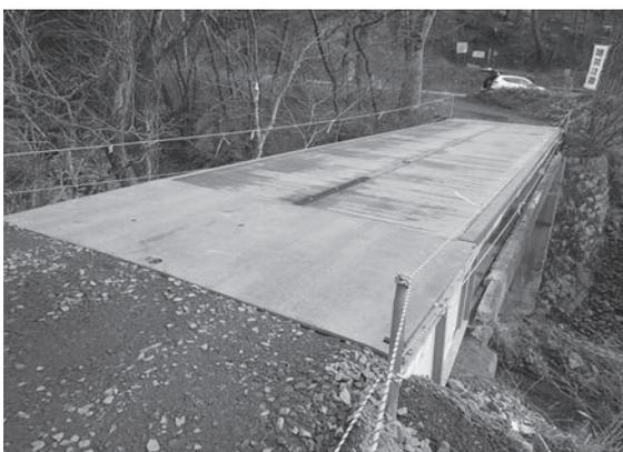
CLTを活用した床板の試験施工
