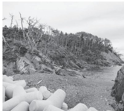
枯木伐採・除去計画箇所
