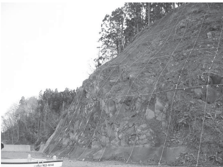
海岸崖地対策施工箇所「今朝磯」：本吉町今朝磯地内
