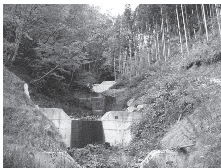
大崎市鳴子温泉中道 (山腹崩壊危険地区)
