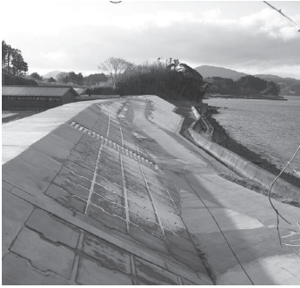
「波伝谷」：海岸線沿いに残る旧防潮堤と完成した新防潮堤
