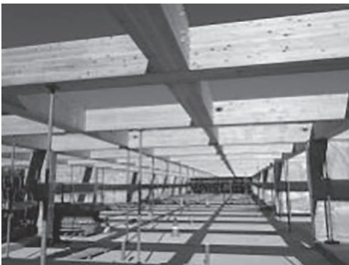
FSC 集成材の施工状況
