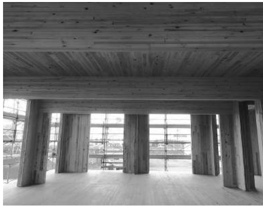
天井や床、壁にCLTを使用
