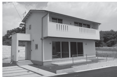
完成した木造災害公営住宅
