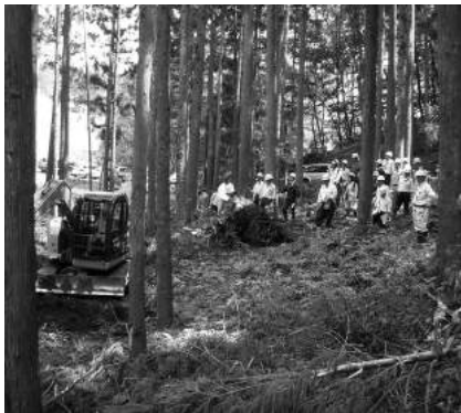
森林作業道作設
