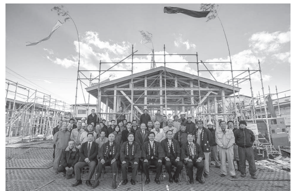
登米市木造災害公営住宅建設推進協議会 『地元協議会方式による木造災害公営住宅の建設』
