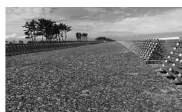
盛土造成後の様子 乾燥防止に木質チップを敷き詰め
