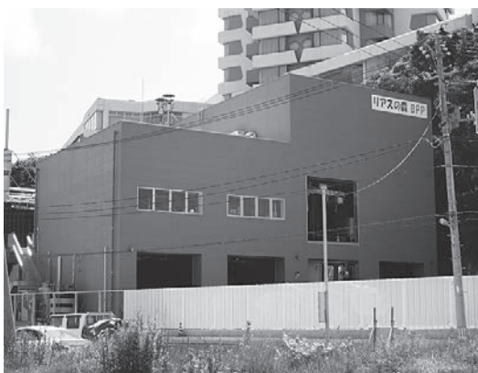
発電プラントの外観
