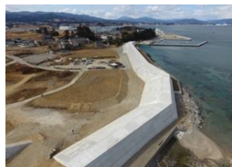
海岸防災林の造成（崎野：気仙沼市）
