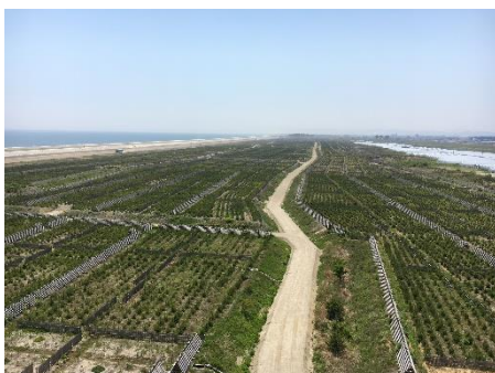
復旧が進められている海岸防災林
