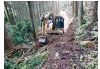
保育作業のための森林作業道整備
