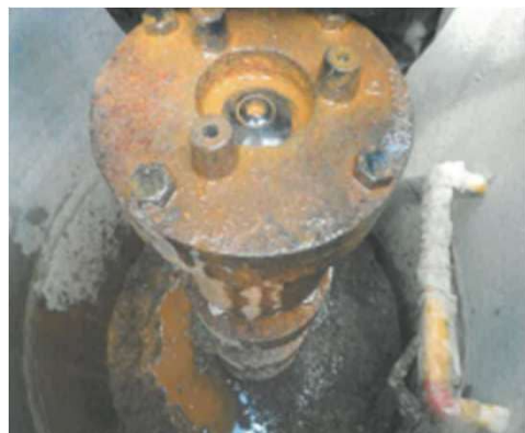
空気弁等の劣化や不具合状況(例)
