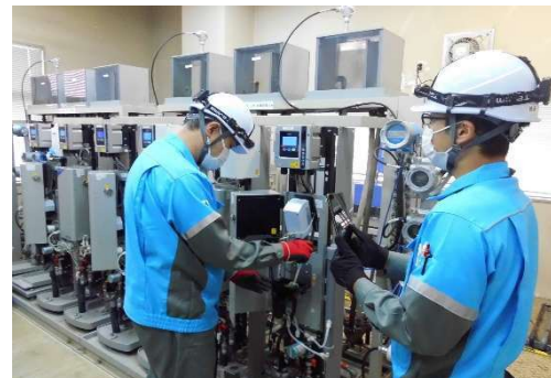
設備点検状況
