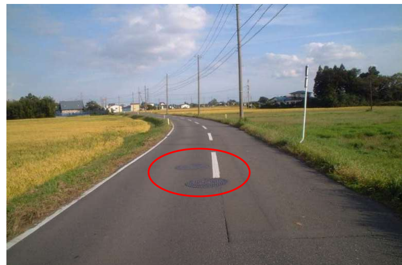
補修箇所(加美町B1-7,B工1-5)
