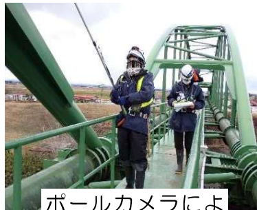
ポールカメラによる 近接目視点検
