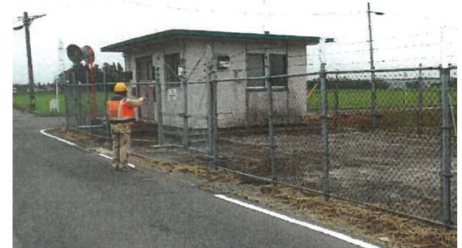
幹線テレメータ室の巡視状況
