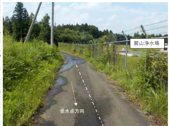
管理設区間の状況
