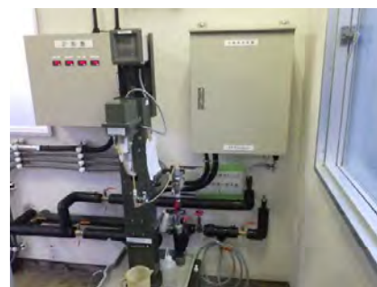
末端受水水質監視装置点検状況
