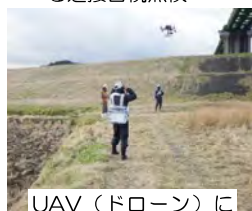
UAV(ドローン)による 近接目視点検
