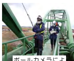
ポールカメラによる 近接目視点検
