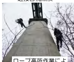
ロープ高所作業による 近接目視点検
