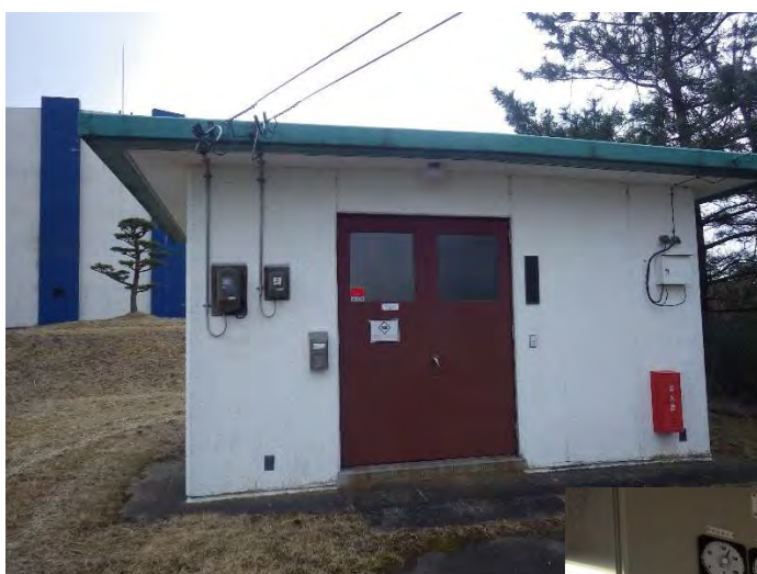
●三本木受水テレメータ室外観
