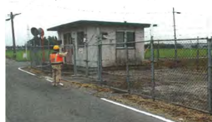
幹線テレメータ室の巡視状況
