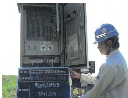
電気防食設備点検状況
