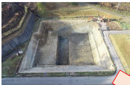
掘削完了後 (R1. 10月末)
