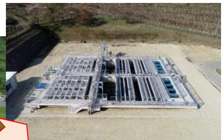
施設完成 (R3. 4月)
