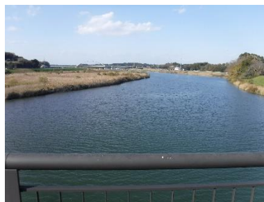
採水地点の様子（鳴瀬川・小野橋）
